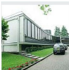
La struttura L'ex centro Rai
